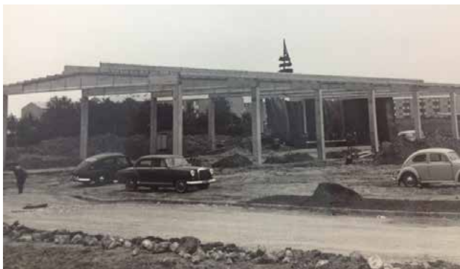
Opførelse af lagerhal, Metalbuen 28, i 1961
